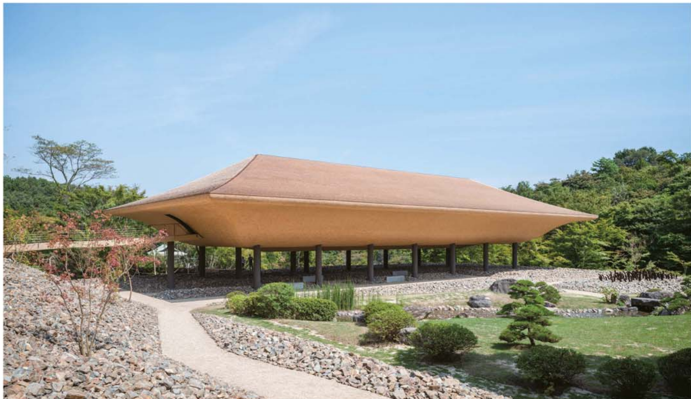
【建築概要】 敷地面積：4700㎡ 建築面積：796㎡ 全長：46m 構造：鉄骨造 屋根：柿葺き 軒天井：サワラ材
